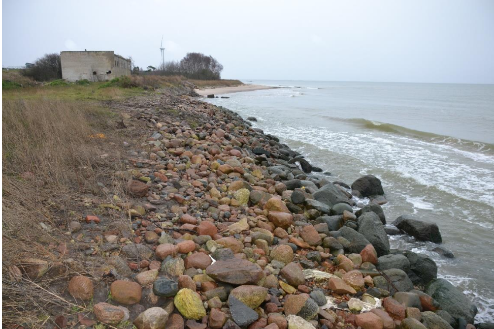
6.attēls. Mākslīgo krastu iecirknis ar laukakmeņu rip-rap un gabionu preterozijas būvēm pie Liepājas NAI.
